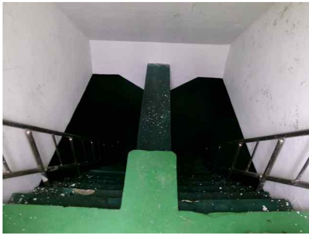
검수실 내부 전경
