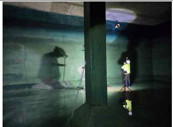
배수지 2지 내부 전경
