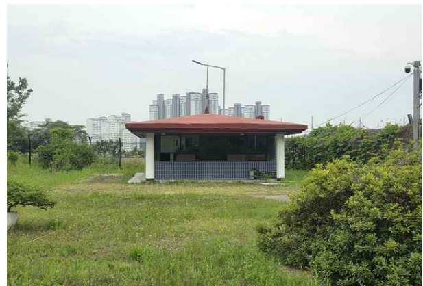
손상내용 관리실 외부 상태양호 손상원인 -
