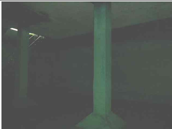
배수지 1지 내부 전경
