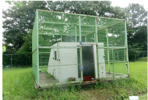
손상내용 검수실 외부 상태양호 손상원인 -
