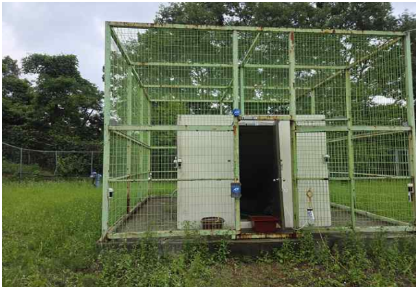
손상내용 검수실 외부 상태양호 손상원인 -
