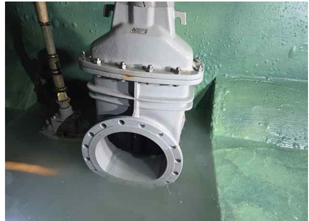
손상내용 2지 유출배관 상태양호 손상원인 -
